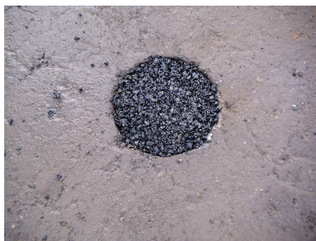
Fot. 6. Otwór nr 3 wypełniony masą bitumiczną po zakończeniu badań.
