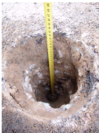
Fot. 2. Odwiert nawierzchni w otworze nr 1.
