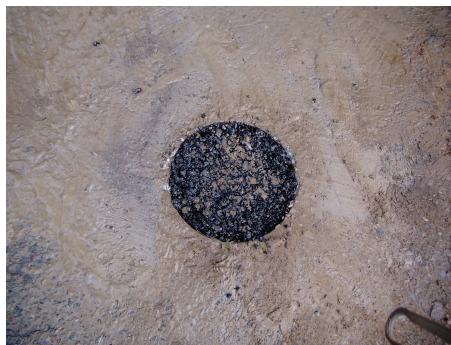
Fot. 12. Otwór nr 6 wypełniony masą bitumiczną po zakończeniu badań.
