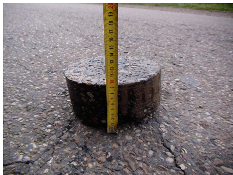
Fot. 11. Rdzeń pobrany z nawierzchni drogowej w otworze nr 6.
