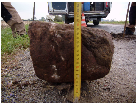
Fot. 9. Rdzeń pobrany z nawierzchni drogowej w otworze nr 5.
