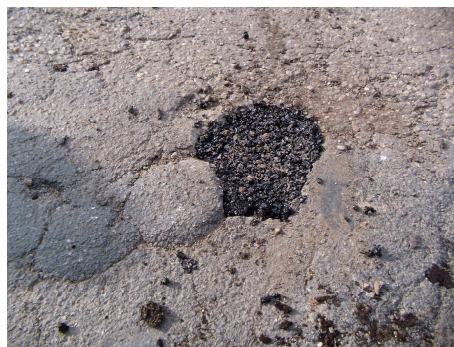
Fot. 10. Otwór nr 5 wypełniony masą bitumiczną po zakończeniu badań.
