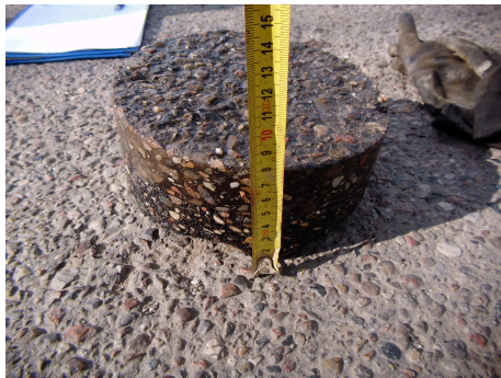
Fot. 7. Rdzeń pobrany z nawierzchni drogowej w otworze nr 4.
