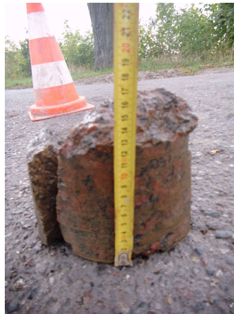
Fot. 8. Rdzeń pobrany z nawierzchni drogowej w otworze nr 4.
