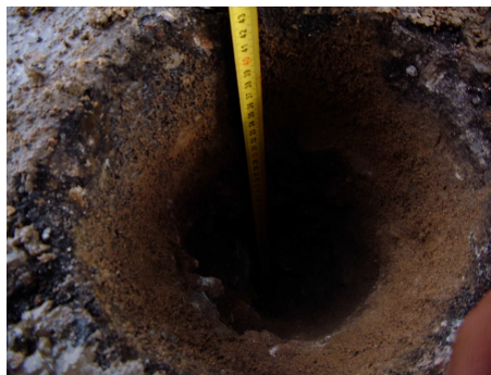
Fot. 4. Odwiert nawierzchni w otworze nr 2.
