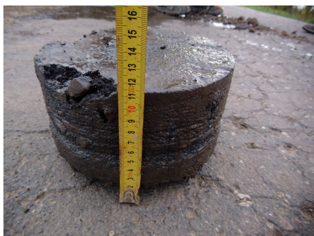
Fot. 5. Rdzeń pobrany z nawierzchni drogowej w otworze nr 3.
