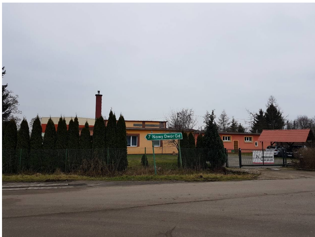
Zdjęcie nr 3: – km 0+045 L istniejące oznakowanie pionowe do przestawienia poza chodnik
