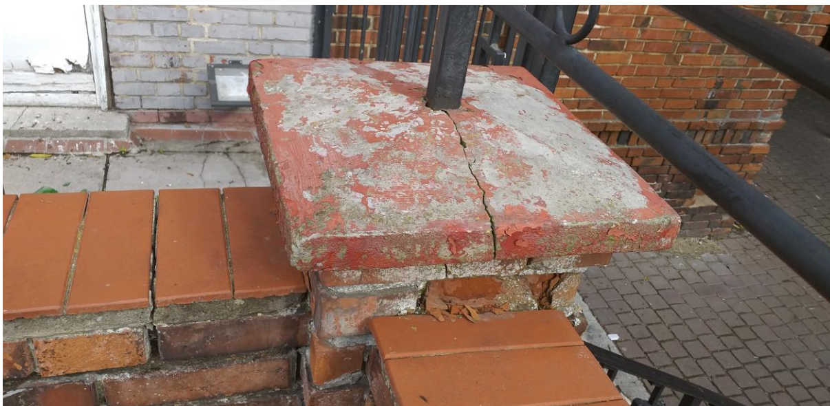
29. Widok daszku filara balustrady tarasu południowego hotelu Niemieckiej Wspólnoty Narodowej.
