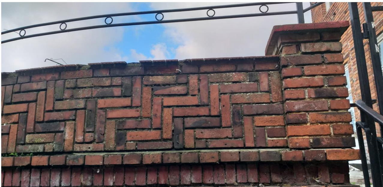
15. Widok fragmentu balustrady tarasu południowego hotelu Niemieckiej Wspólnoty Narodowej, od strony wschodniej.
