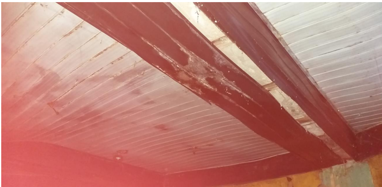
45. Widok stropu we wnętrzu piwnicy pod tarasem południowym hotelu Niemieckiej Wspólnoty Narodowej. Fot. M. Gmiter 9.10.2019 r.
