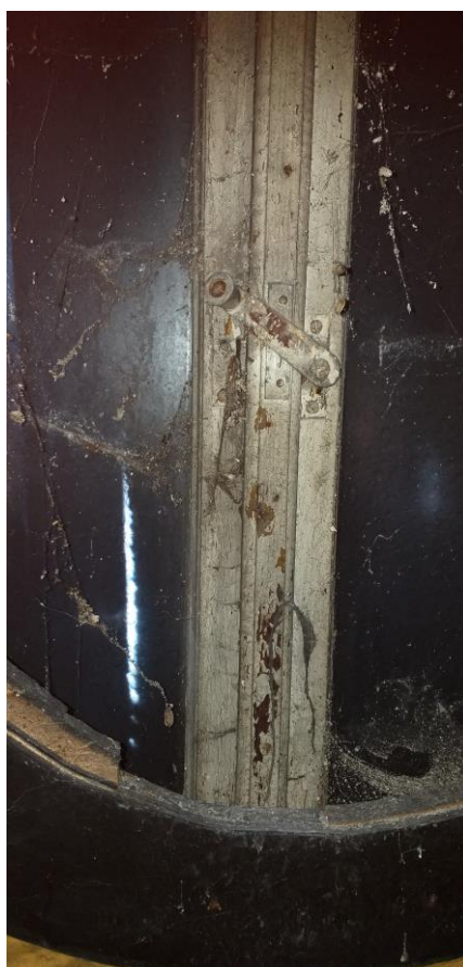
46. Widok oryginalnego okna we wnętrzu piwnicy pod tarasem południowym hotelu Niemieckiej Wspólnoty Narodowej.
