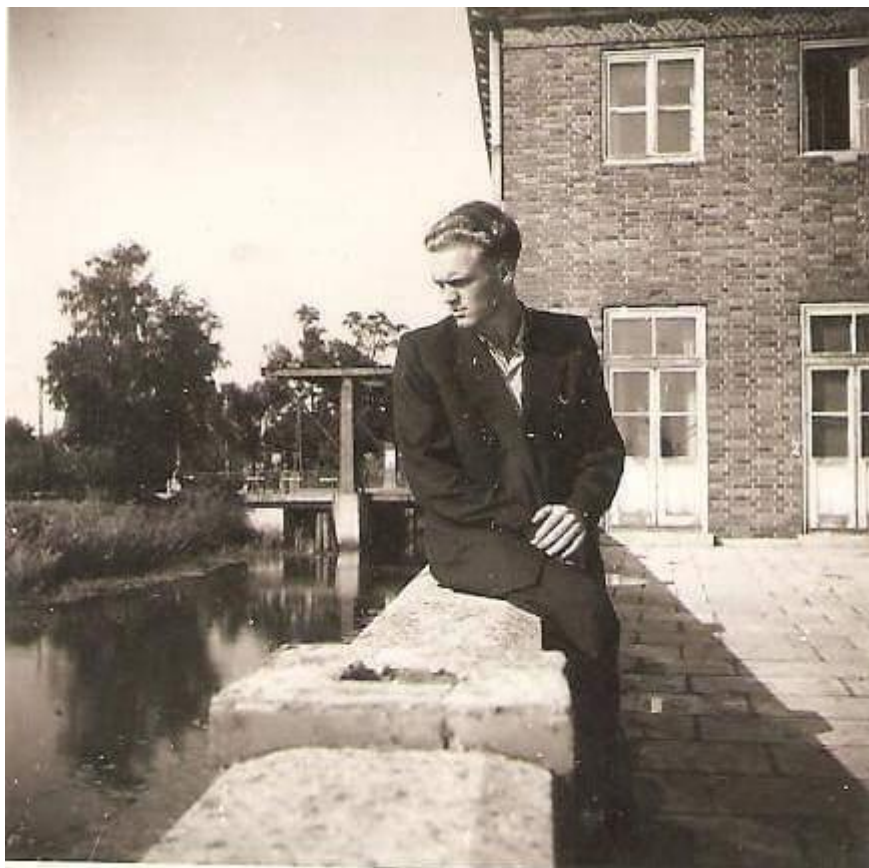
7. Widok balustrady tarasu hotelu Niemieckiej Wspólnoty Narodowej od strony zachodniej.
