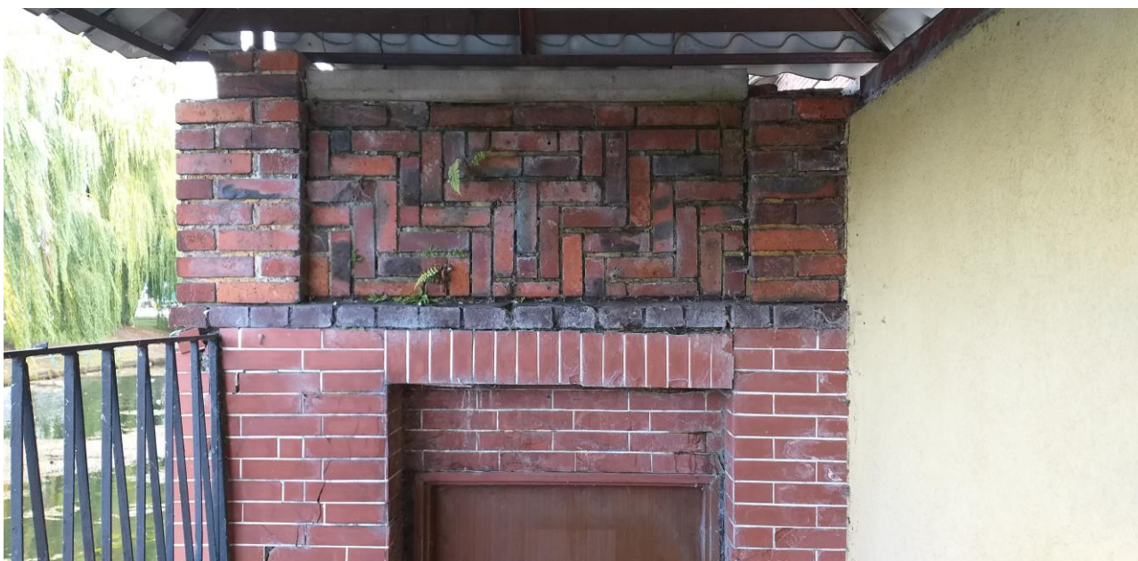
20. Widok górnej części balustrady nad zejściem do piwnic pod tarasem hotelu Niemieckiej Wspólnoty Narodowej.
