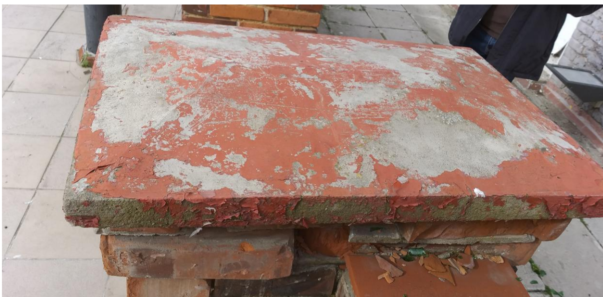
28. Widok daszku filara balustrady tarasu południowego hotelu Niemieckiej Wspólnoty Narodowej.
