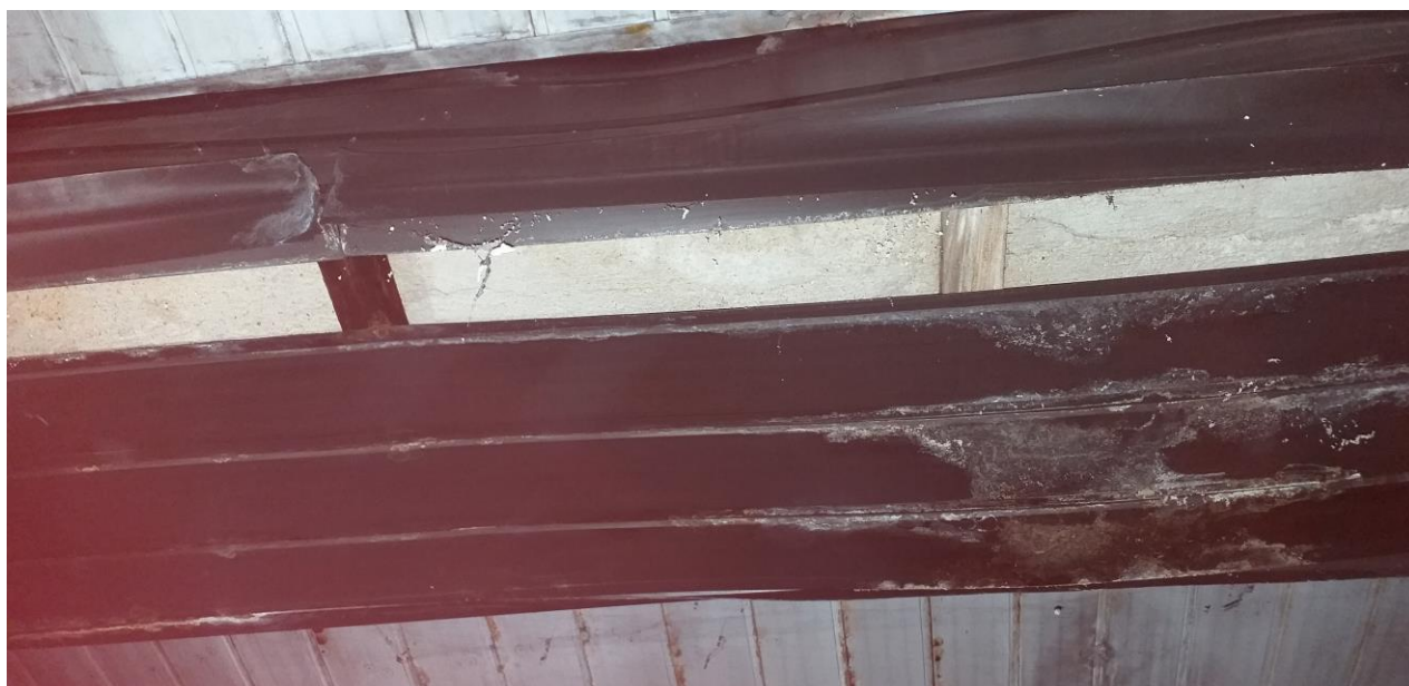
44. Widok stropu we wnętrzu piwnicy pod tarasem południowym hotelu Niemieckiej Wspólnoty Narodowej.
