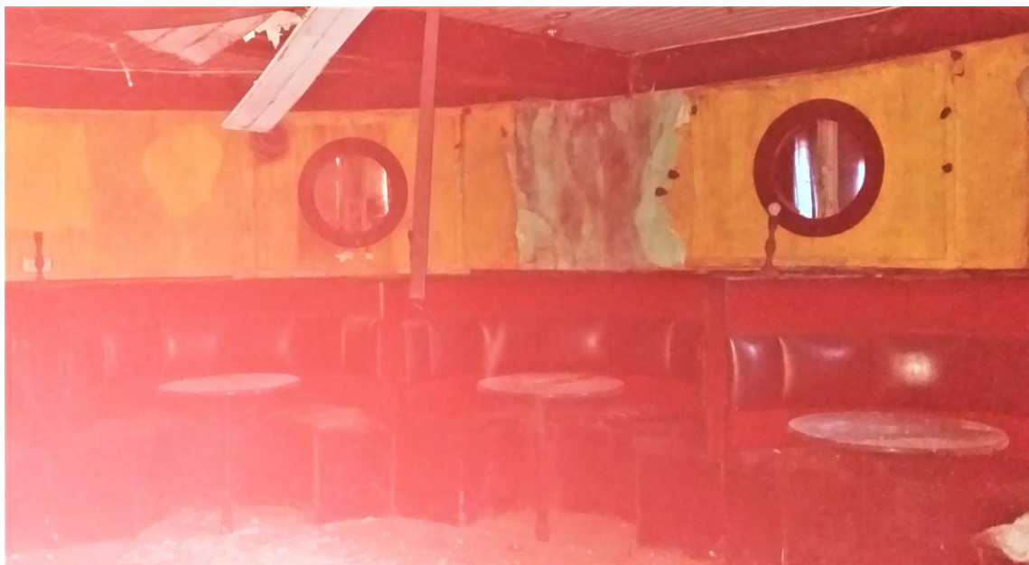
41. Widok wnętrza piwnicy pod tarasem południowym hotelu Niemieckiej Wspólnoty Narodowej.
