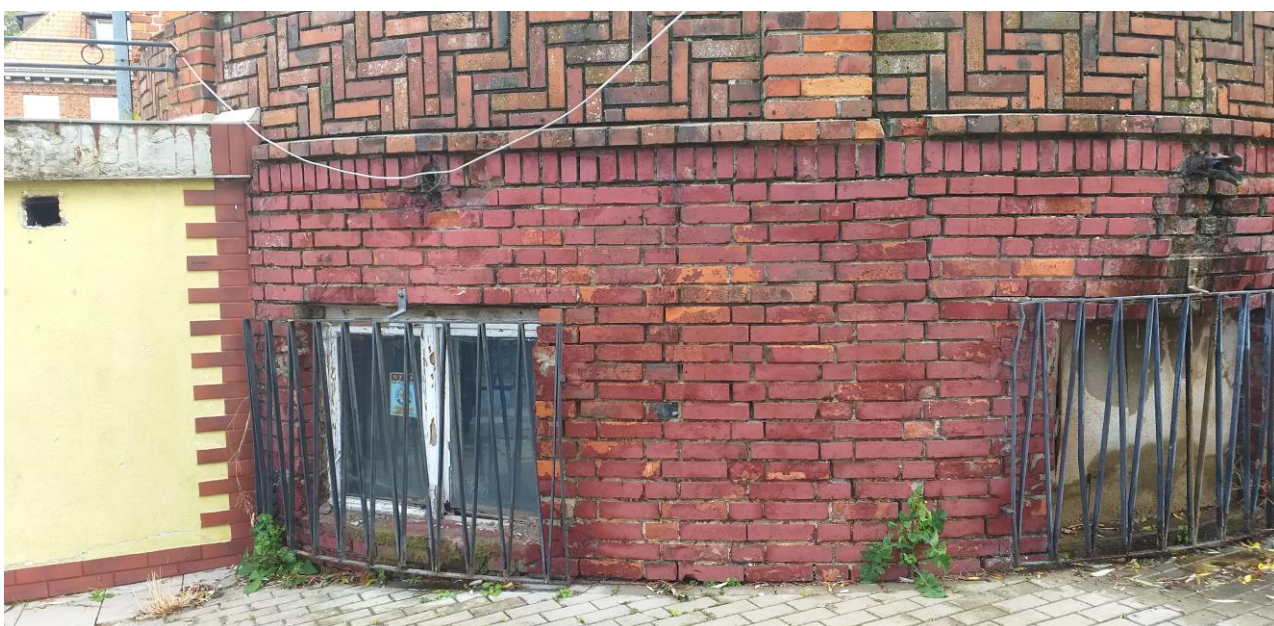
18. Widok środkowego i zachodniego okna tarasu południowego hotelu Niemieckiej Wspólnoty Narodowej.
