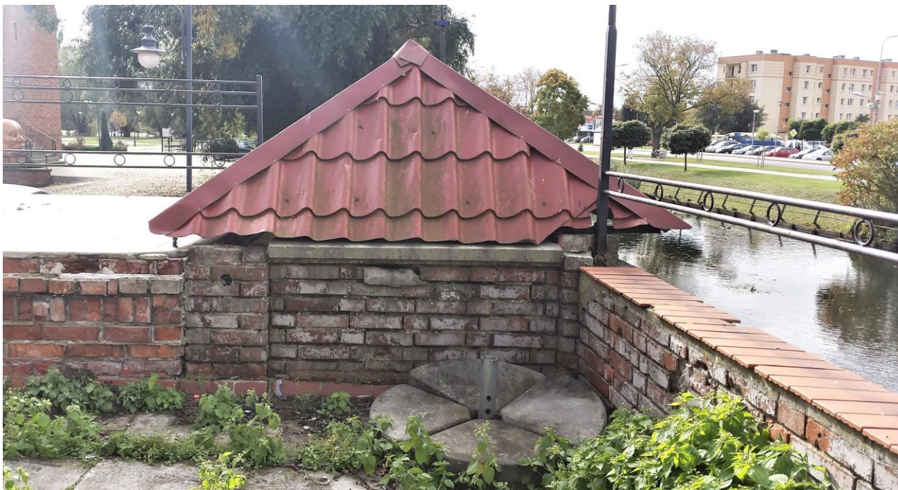
21. Widok jedyne oryginalnego fragmentu balustrady nad zejściem do piwnic, od wnętrza tarasu hotelu Niemieckiej Wspólnoty Narodowej. Po lewej stronie widoczny wtórny mur w miejscu dawnych schodów.
