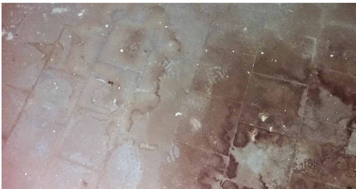
42. Widok posadzki we wnętrzu piwnicy pod tarasem południowym hotelu Niemieckiej Wspólnoty Narodowej.
