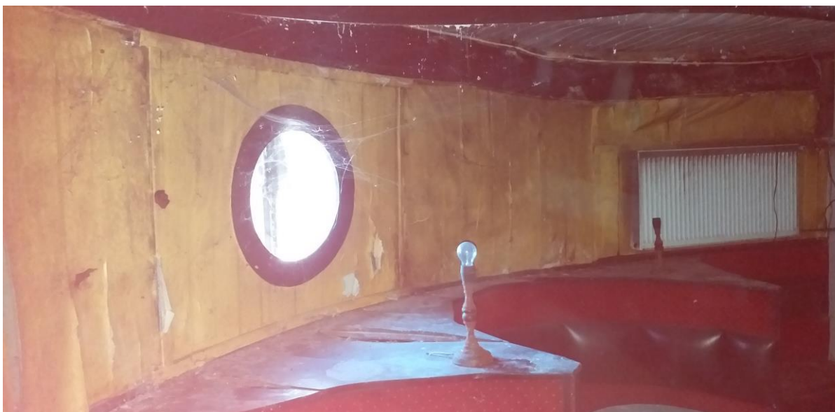
40. Widok wnętrza piwnicy pod tarasem południowym hotelu Niemieckiej Wspólnoty Narodowej. Fot. M. Gmiter 9.10.2019 r.
