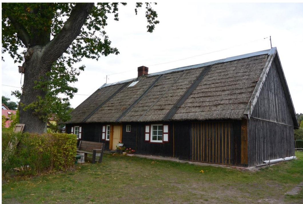
Chata rybacka Jantar – stan po remoncie
