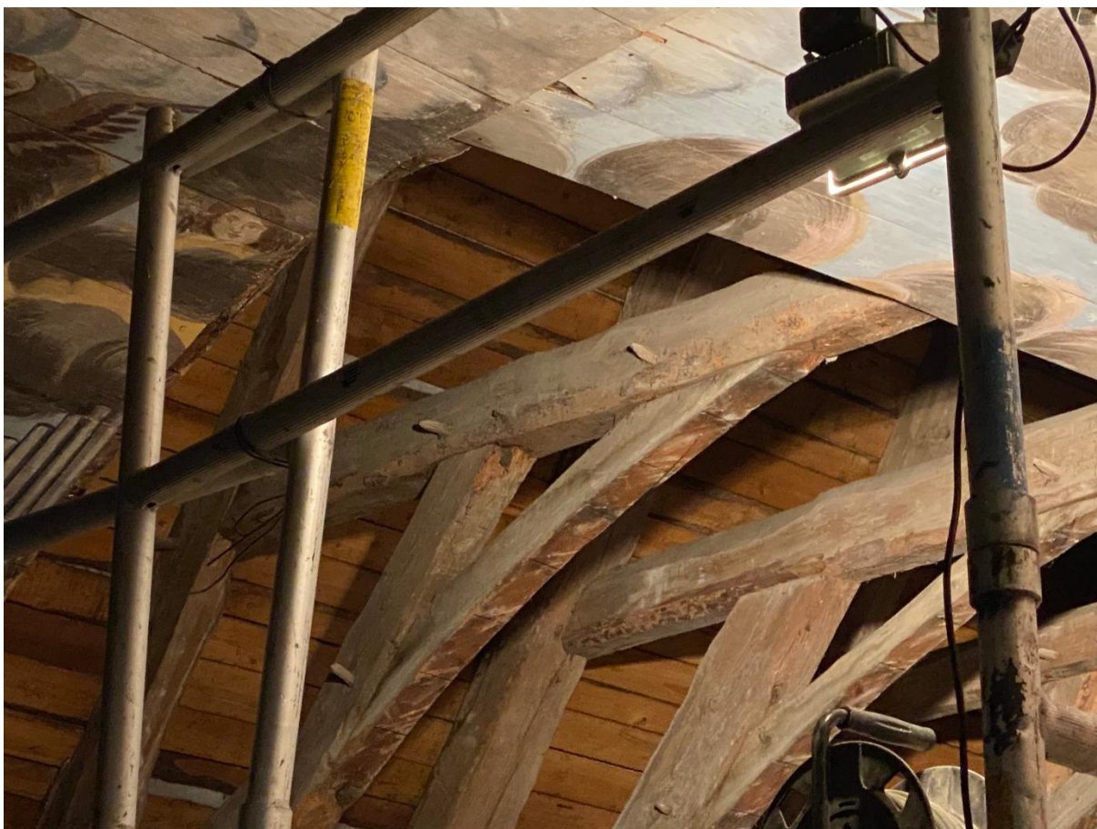
Kościół p.w. Św. Elżbiety Węgierskiej w Lubieszewie – strop przed pracami konserwatorskimi
