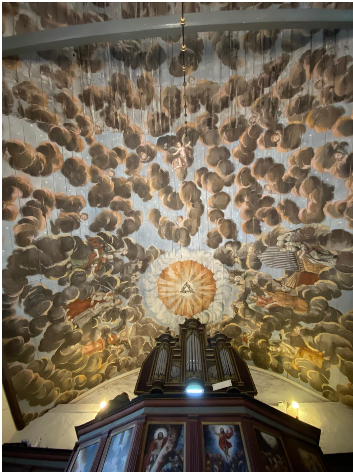
Kościół p.w. Św. Elżbiety Węgierskiej w Lubieszewie – stan po konserwacji stropu
