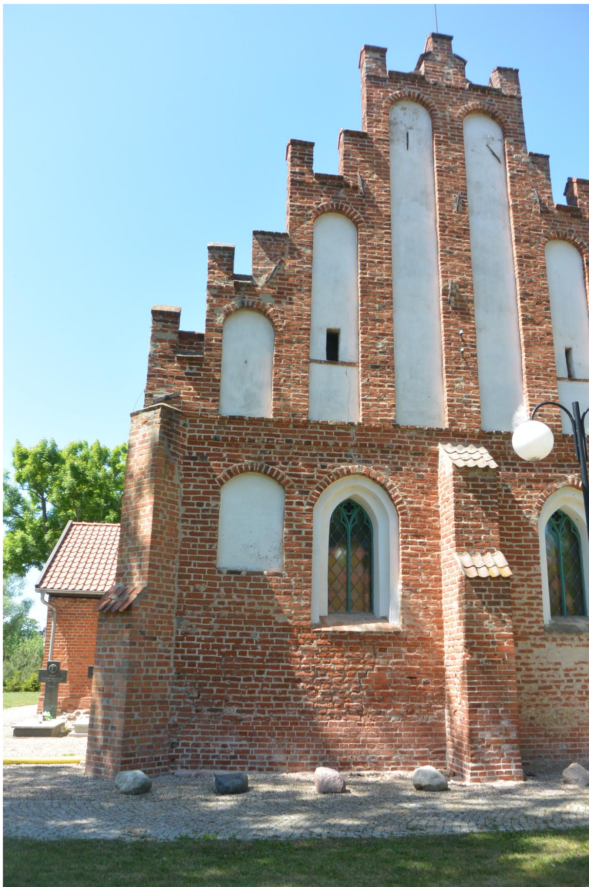
Kościół p.w. Św. Mikołaja w Żelichowie, ściana wschodnia – stan przed pracami konserwatorskimi
