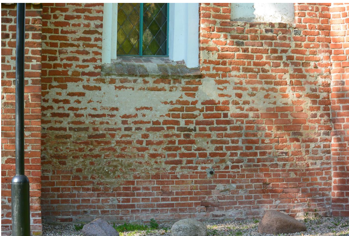
Kościół p.w. Św. Mikołaja w Żelichowie, ściana wschodnia – stan przed pracami konserwatorskimi
