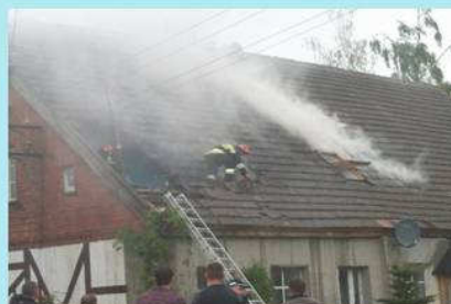
Pożar budynek mieszkalny Jazowa 17.04.2010 r.
