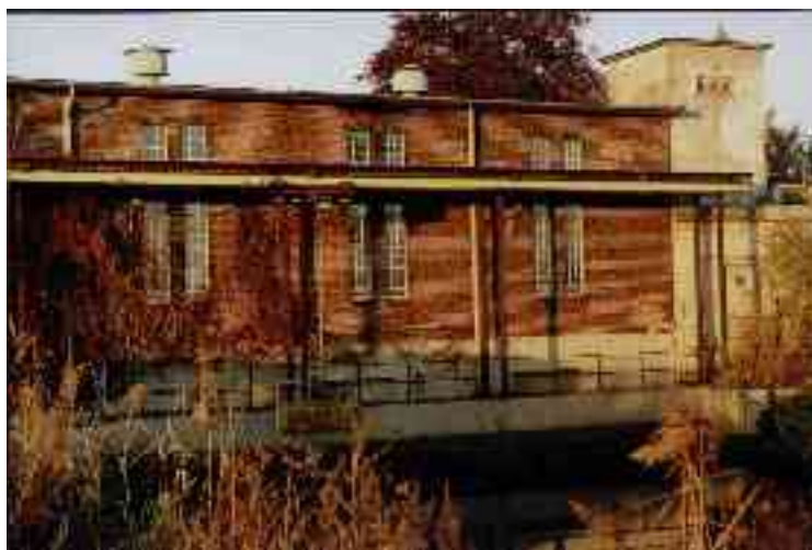
Rybina, przepompownia Chłodniewo, gmina Stegna (fot. Magdalena Wilk)
